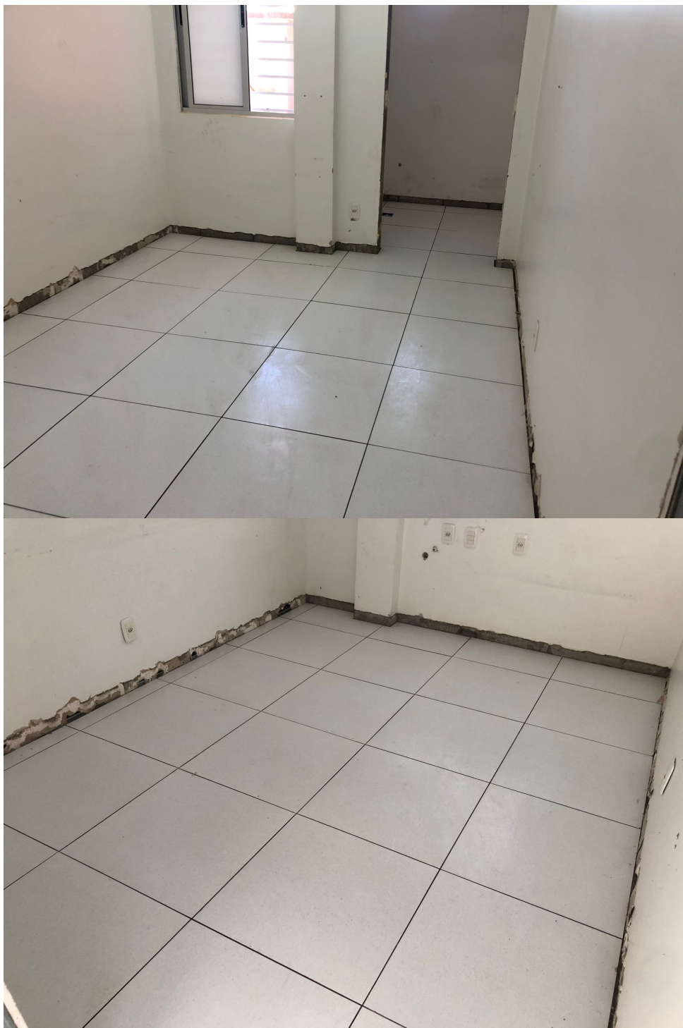
Foto 3: Execução de piso cerâmico.
