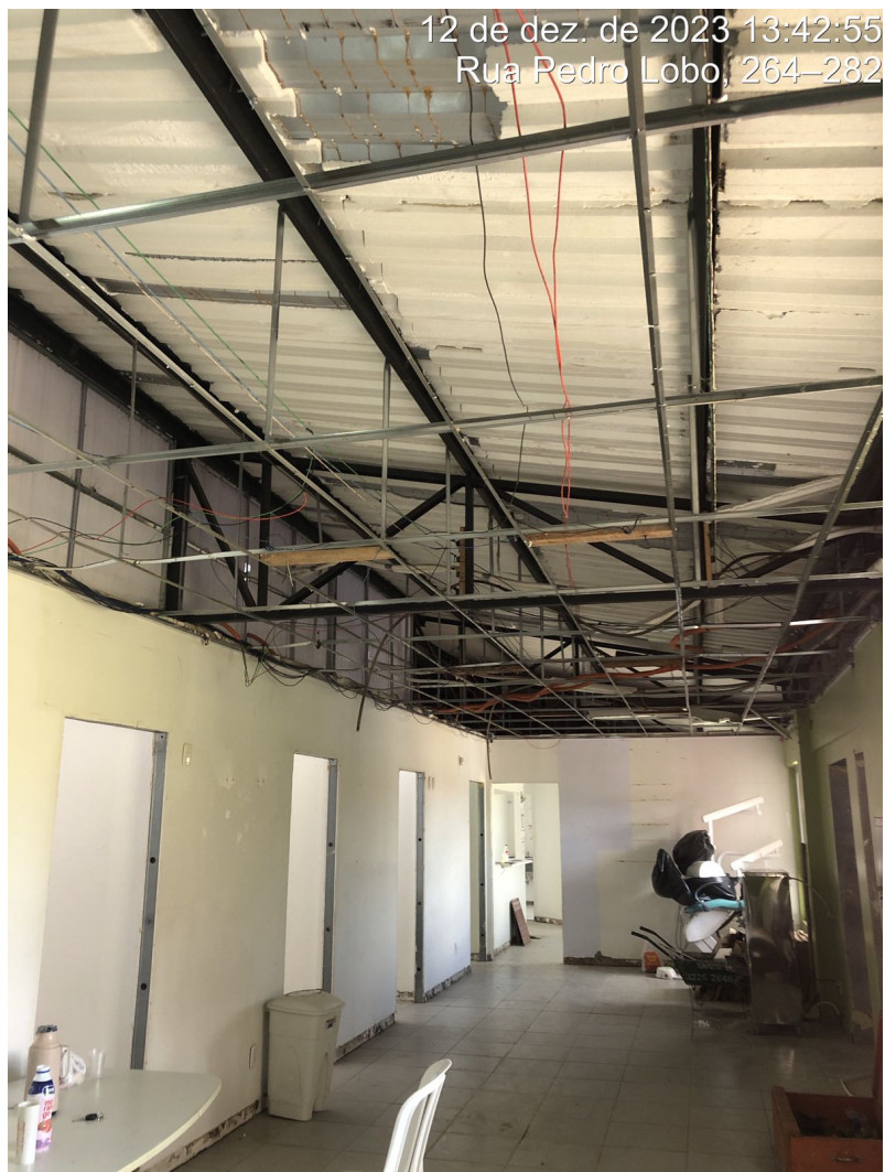
Foto 6: Remoção e troca de forro de PVC.
