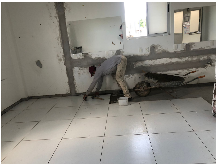
Foto 1: Remoção de Rodapés, piso cerâmico. Execução de piso cerâmico e de tubulações de hidráulica e elétrica.
