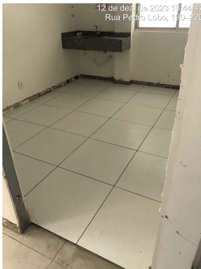
Foto 2: Remoção de Portas.
