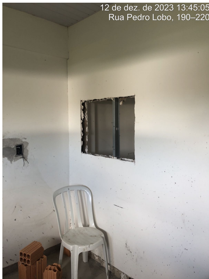
Foto 9: Paredes em drywall. Abertura de óculo.
