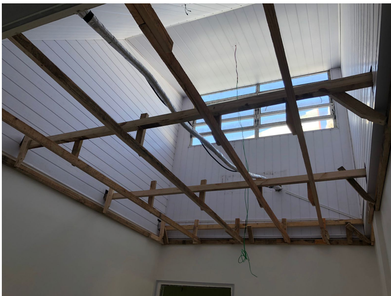
Foto 5: Remoção e troca de forro de PVC. Troca da fiação elétrica.
