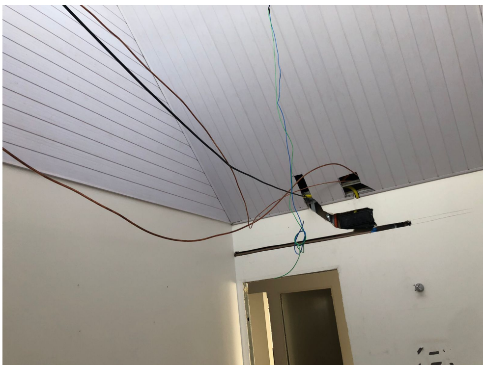
Foto 7: Troca de fiação elétrica e pontos de ar condicionado.
