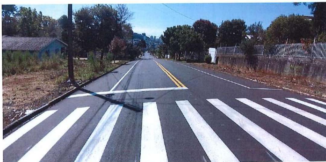
Foto 02: Rua Pedro José da Silva (trecho 02)
