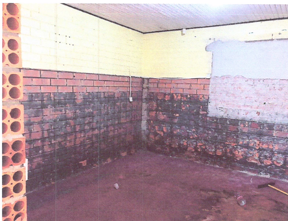
Foto 04: Demolição Revestimento Cerâmico Brinquedoteca
