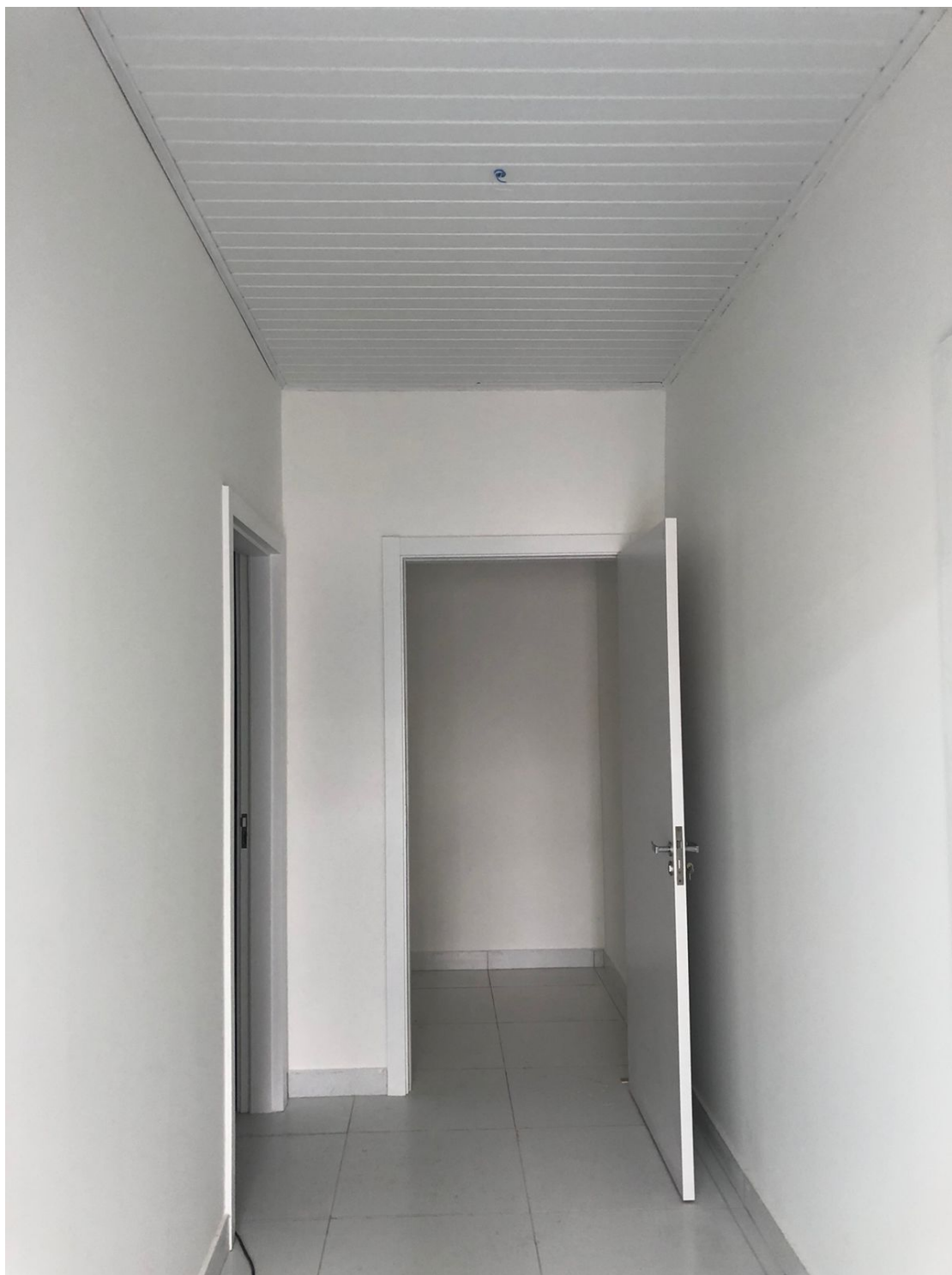
Foto 1: Pintura interna de teto (forro em madeira); portas e paredes.
